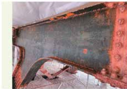
塗布後の初期塗膜酸化反応を抑え、塗膜内部へ深く浸透させる事により、多くの塗膜を除去させる事が可能。
