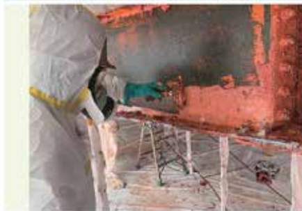
旧塗膜の状態によっては0.50kg / mlでも十分な剥離力を発揮させる事が可能。
